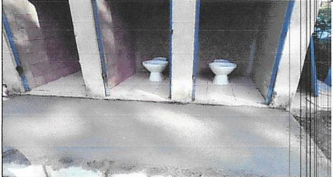
Foto 2 : Mantenimiento de puertas de los baños y sustición de sanitarios
