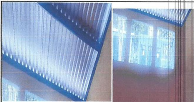
Foto 6; Sustición de lámina por lámina troquilada y cambio de ventanas de metal por ventanas de PVC
