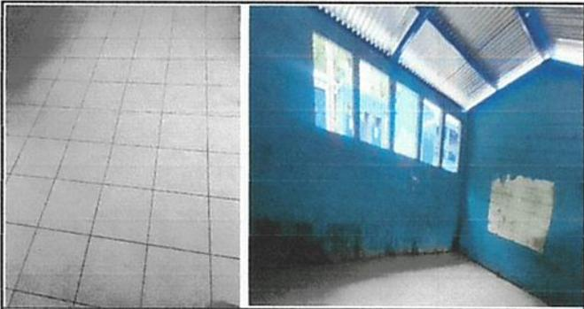
Foto 5: Sustición de piso liso por cerámico y pintura en muros exteriores e interiores
